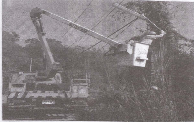
台電主辦 邱英賢 組員 曾科達 高壓電活電作業 清理雜藤樹 合和里里長 林作松陳情 台電美濃服務所即速處理
