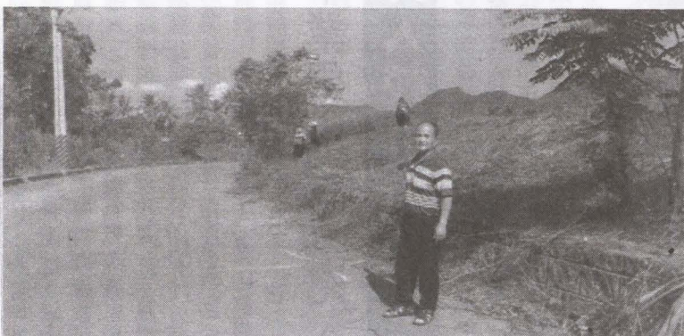
福安里美濃溪河堤(福安庄附近)經里長古龍魁陳情後，目前河川局正派工清除雜草及修剪河堤邊坡的樹木。
