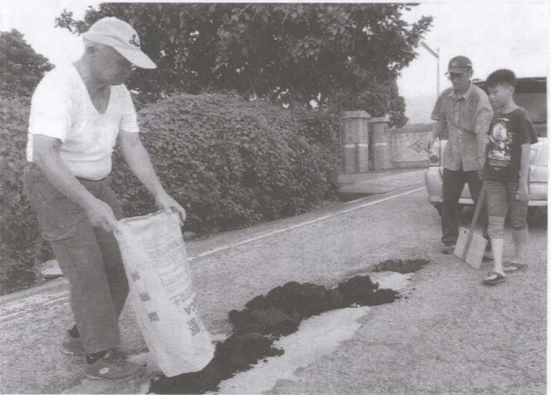
▲圖公所第一時間派員修補柏油路面，里民給予肯定。
